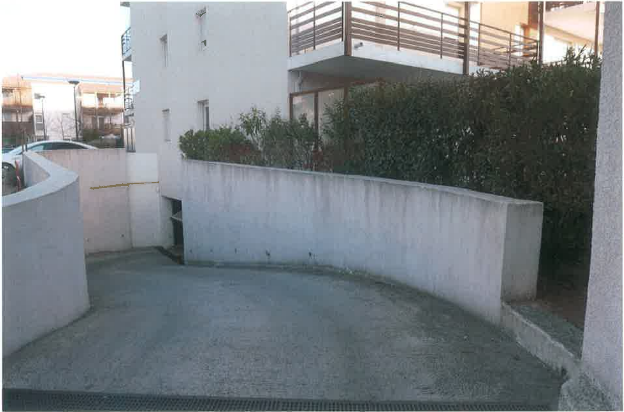
Photo n° 12 (accès garage en sous-sol)
